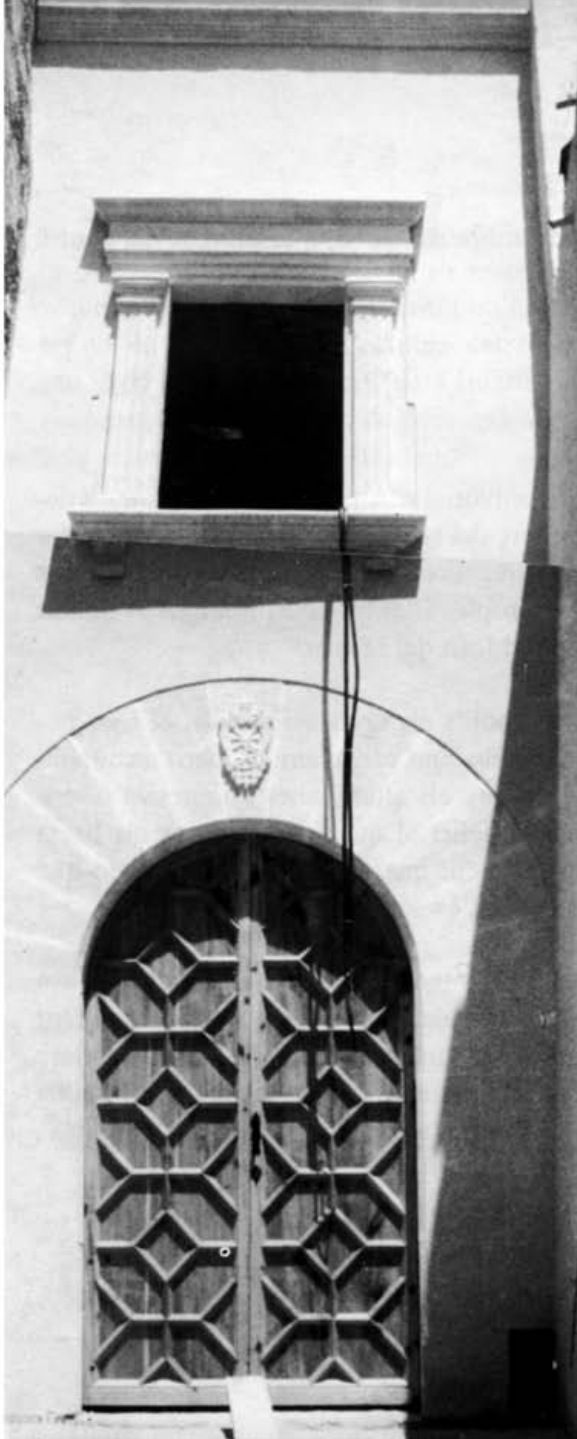
Façana de la casa del Forn del Senyor, un cop enllestida la restauració
